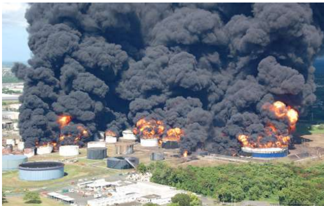
Рис. 38 — Авария на пожаровзрывоопасном объекте
